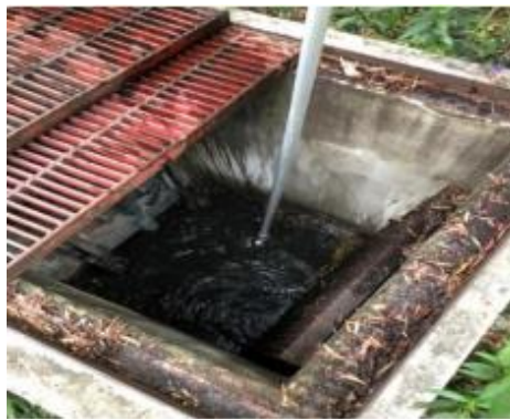
รูปที่ 11 ตะแกรงดักขยะ
